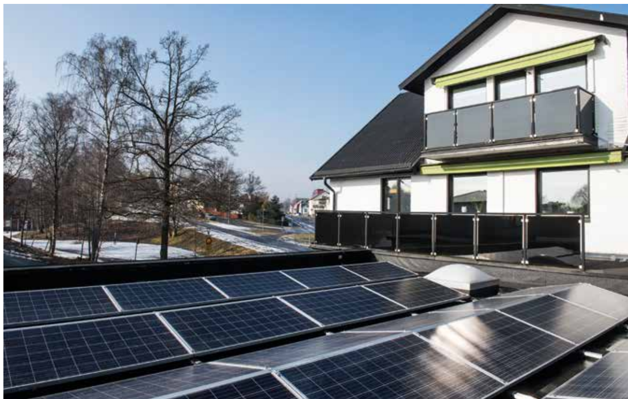
Solcellerna, som täcker taket på delar av Hässlehems kontor, används för elproduktion.
