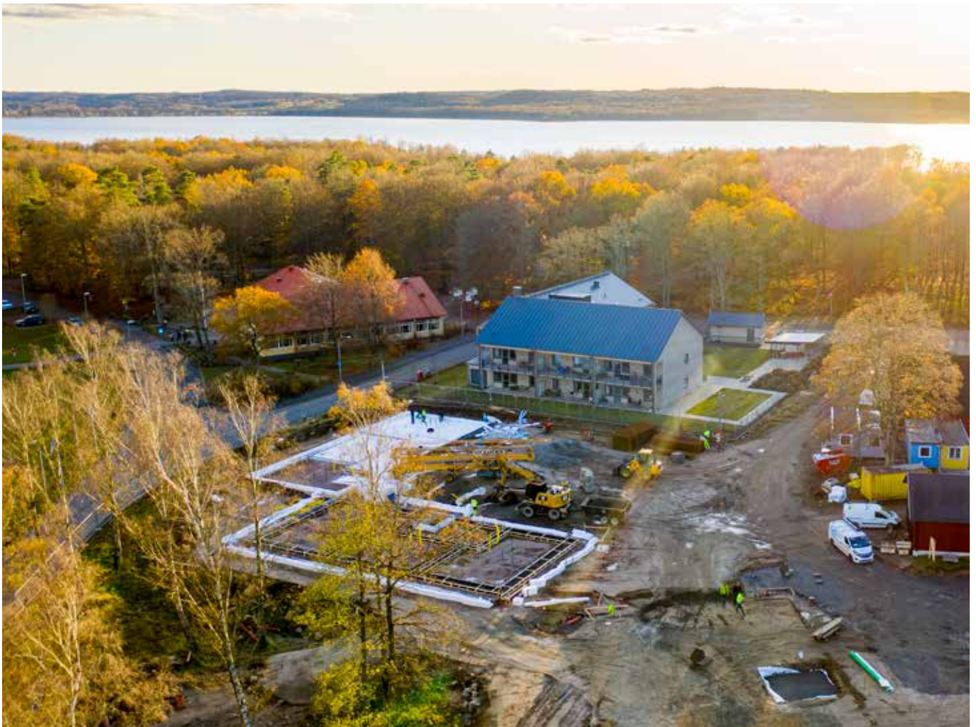
Etapp ett när första huset började byggas på Kanslihusvägen på Garnisonen 2019. Snart inleds etapp två med ytterligare två hus.
