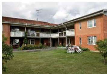
Edvin Widéns väg, Vinslöv 1
