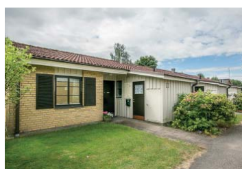
Vinkelgatan, Platos väg, Bjärnum 3
