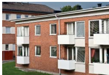
Hantverksgatan, Järnvägsgatan, Tyringe 1
