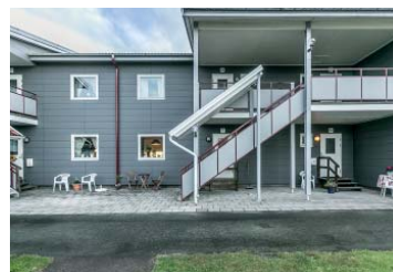
Esplanadgatan, Föreningsgatan, Skolgatan, Sösåala 3
